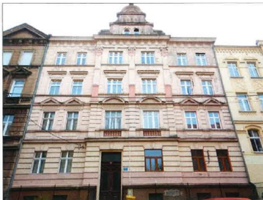
Ogólny widok budynku – elewacja frontowa.
